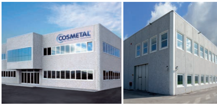
COSMETAL nuovo stabilimento costruito nel 2003, recentemente ampliato nel 2012. COSMETAL, new production plant opened in 2003, recently enlarged in 2012.
